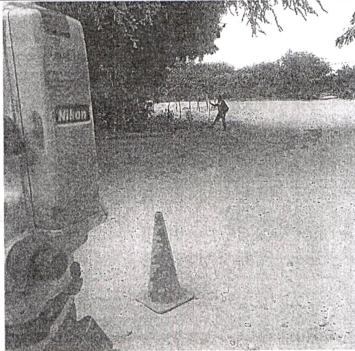
FOTO N° 05.: Levantamiento topográfico Estaciones Total Nikon modelo DTM-332
