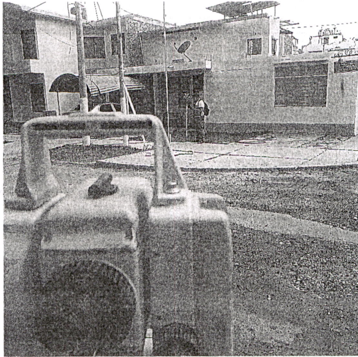
FOTO N° 03: Levantamiento topografico. Veredas.
