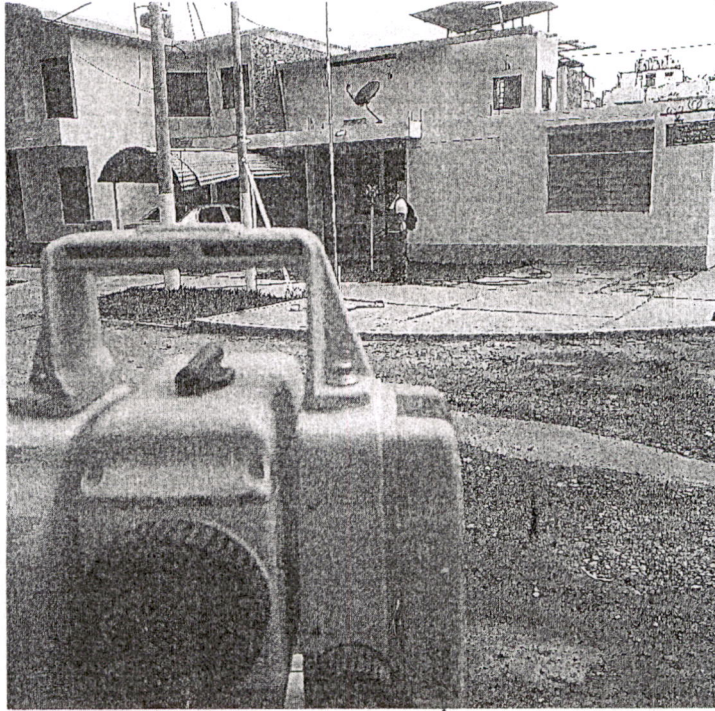
FOTO N° 03: Levantamiento topografico. Veredas.
