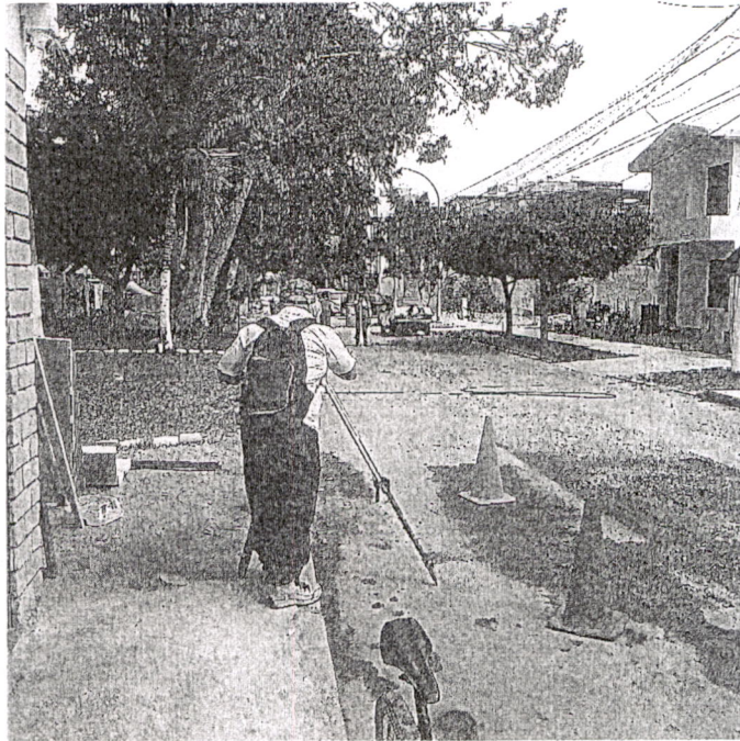
FOTO N° 01. LEV. TOPOGRAFICO AVENIDA B (Cuadrilla y equipos utilizados)
