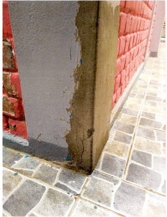
Fotos N°03 y 04: A pesar de los resanes efectuados por la APAFA, las columnas aparecen fisuradas en varios sectores del módulo.
