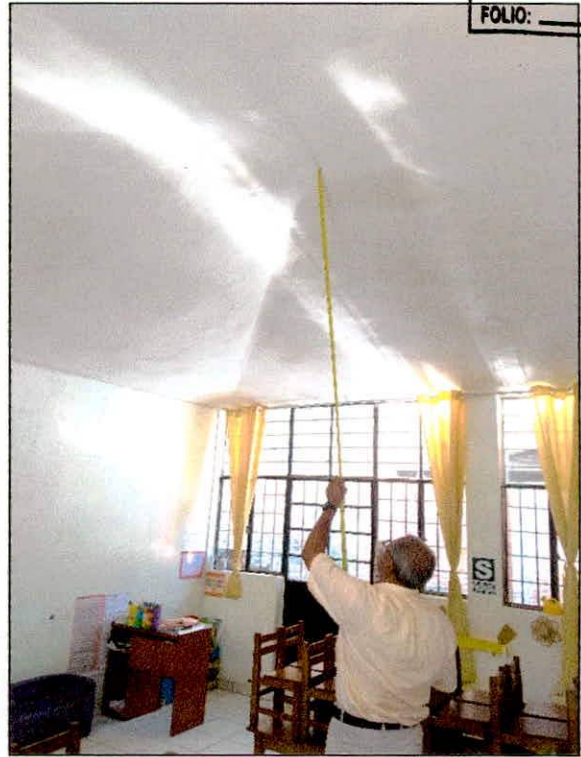
Fotos N°06 y 07: Vista interior del aula común 03 del módulo 1, se verifica el ondeo del falso cielorraso, el mismo que se ve afectado por la incidencia de lluvias. Las instalaciones eléctricas se encuentran expuestas con canaletas porque las tuberías empotradas no permiten mantenimiento alguno. También se aprecia que la misma no cumple el área reglamentaria para un aula del nivel inicial de acuerdo a la normatividad vigente a pesar de tener una altura óptima para ventilación del recinto.
