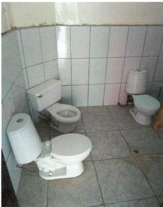
Fotos N°10 y 11: SS.HH. de niños y niñas fuera de la normativa, con acabados en mal estado, tabiques improvisados, fallas estructurales en columnas.
