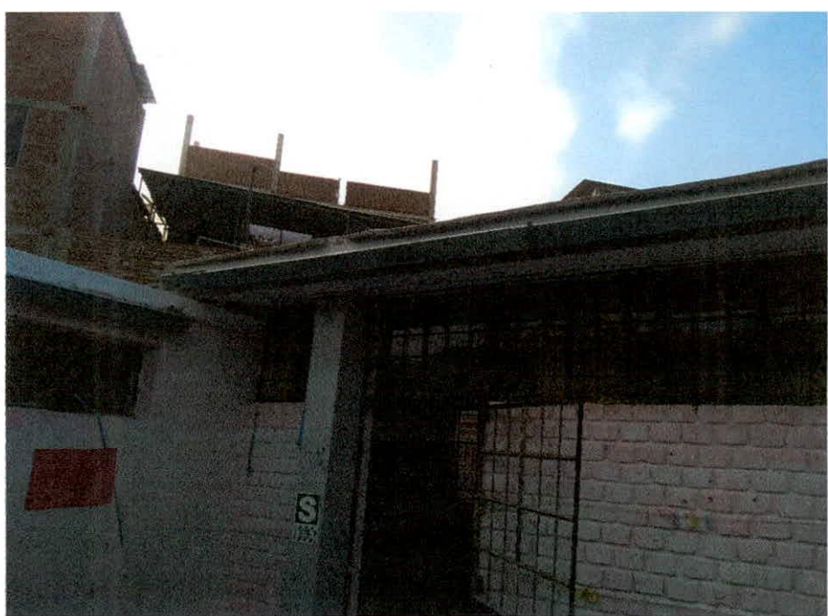
Fotos N°01 y 02: Vista elevación del Módulo 1 con problemas en las cubiertas de ladrillo pastelero en los techos, estas filtraciones han causado que los elementos estructurales presenten problemas. Las últimas lluvias obligaron a la APAFA a intervenir mediante la implementación de un sistema de canaletas el cual presenta fallas.
