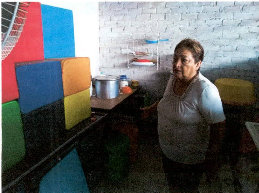
Foto N°26: Vista de la cocina, en malas condiciones se preparan los alimentos para los niños. No cuenta con la infraestructura adecuada para la manipulación de alimentos, sumado a lo precaria de la estructura y las instalaciones eléctricas y sanitarias, el ambiente no cumple con las normas vigentes del RNE.
