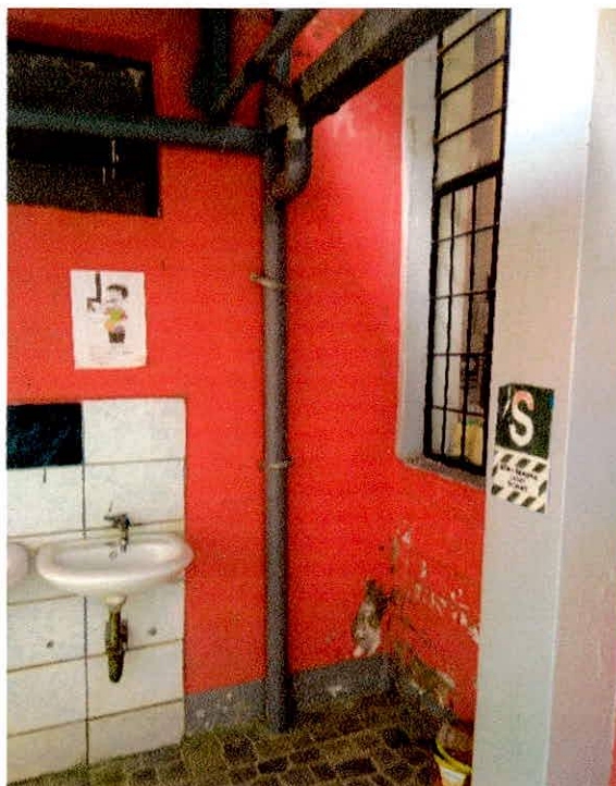
Foto N°08: Improvisación de canaletas y bajantes de tuberías de desagüe pluvial que aún no han solucionado el problema de filtraciones al interior de las aulas.
