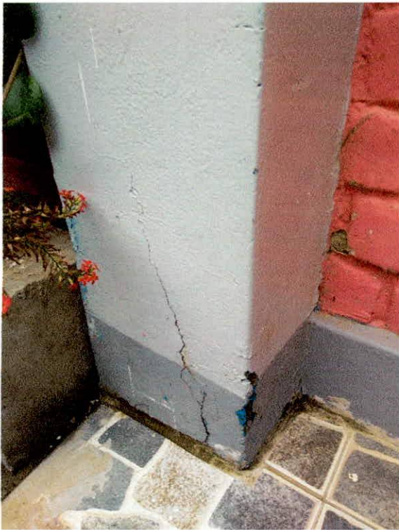
Fotos N°03 y 04: A pesar de los resanes efectuados por la APAFA, las columnas aparecen fisuradas en varios sectores del módulo.
