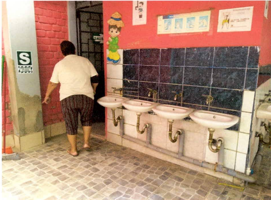
Foto N°12: Bateria de 08 lavatorios solo para el uso de niños, para el caso de las niñas solo existe 01 lavatorio.
