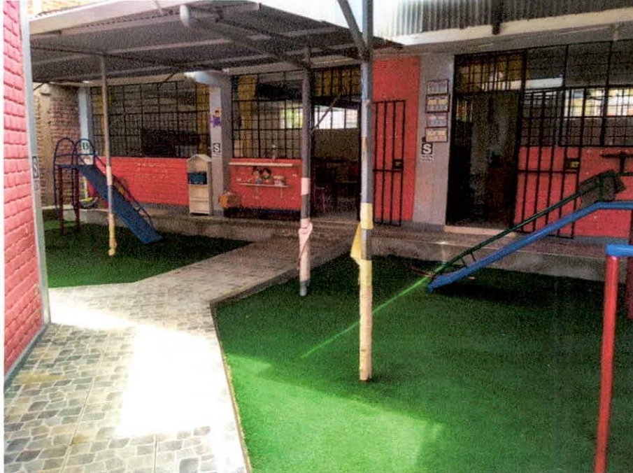
Foto N°32 y 33: Las áreas verdes se encuentran en buen estado. El área de juegos y aulas exteriores de la I.E cuenta con una cobertura de calamina y se establece sobre piso alfombrado. Lamentablemente no se ha previsto un buen diseño estructural en estas coberturas porque existen columnas metálicas que podrían causar accidentes.
