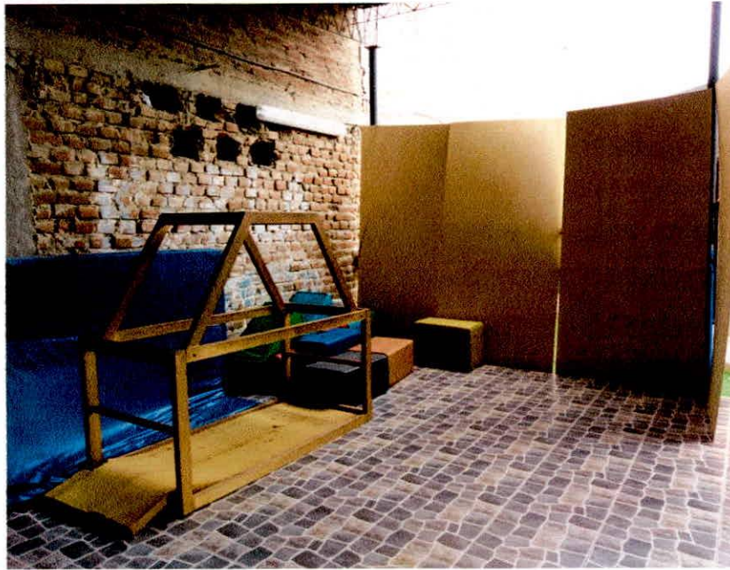
Foto N°27: Vista del Depósito, en malas condiciones. No cuenta con la infraestructura adecuada, sumado a lo precaria de la estructura y no cuenta con instalaciones eléctricas y sanitarias, el ambiente no cumple con las normas vigentes del RNE.
