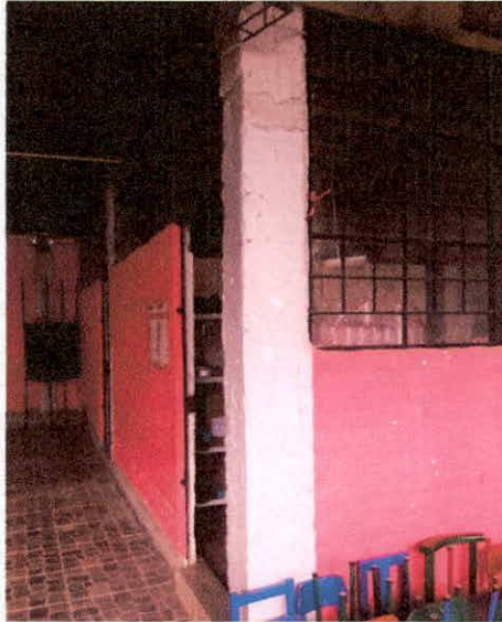
FOTO N° 15: Vista exterior de Cocina.
