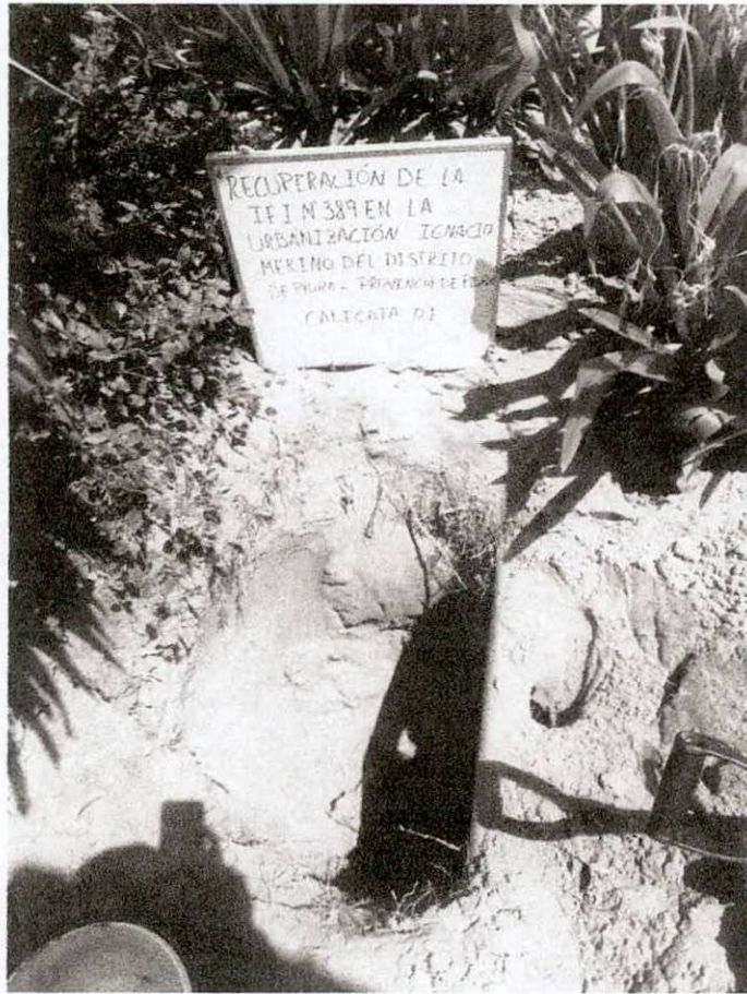
FOTO N° 01: Calicata C - 1. Perfil de la calicata.
