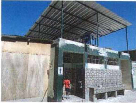
SOBRETECHO CON COBERTURA METALICA EN LOS SS. HH Y MURO DEL MÓDULO 4 AFECTADOS POR LA HUMEDAD.
