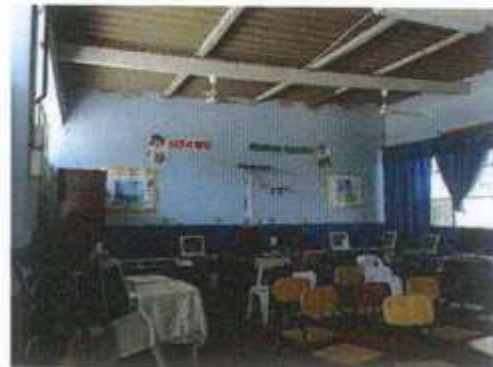
COBERTURA DE PLANCHA COLOR GRIS DE ASBESTO CEMENTO ANTIGUEDAD MAS DE 20 AÑOS
