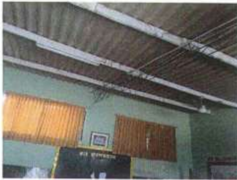
COBERTURA DE PLANCHA COLOR GRIS DE ASBESTO CEMENTO ANTIGUEDAD MAS DE 20 AÑOS
