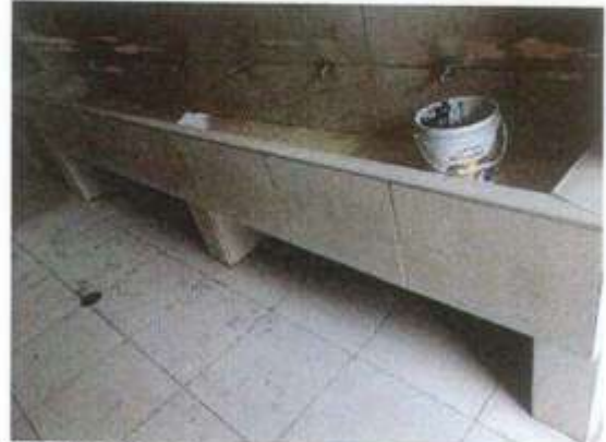
VISTA INTERIOR DEL SS.HH MUJERES LAVADERO CORRIDO
