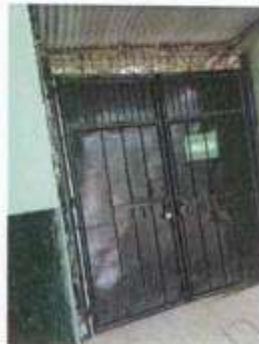
PUERTA DE INGRESO A INICIAL
