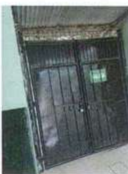
PUERTA DE INGRESO A INICIAL
