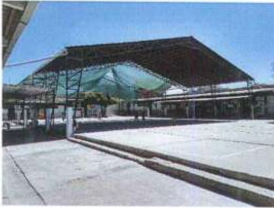
VEREDA DE DESCARGA DE AGUA DE LLUVIA.
