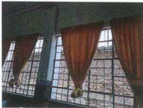
EL MÓDULO 3 NO CONTEMPLA EL RETIRO NORMATIVO AFECTANDO LA VENTILACIÓN CRUZADA AL INTERIOR.
