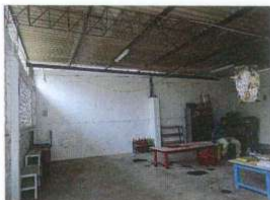
INTERIOR DEL AULA DE 3 AÑOS
