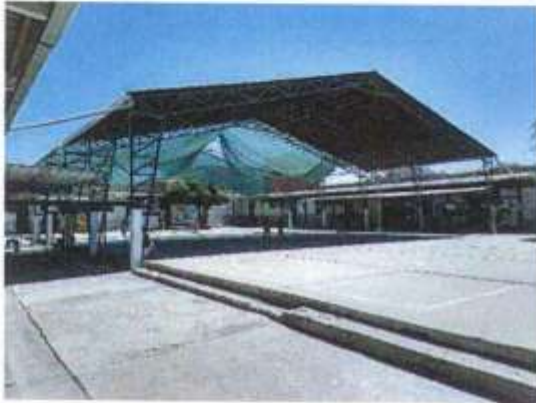
VEREDA DE DESCARGA DE AGUA DE LLUVIA.
