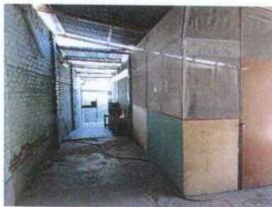
ESTADO ACTUAL DE MUROS DE AULAS-MÓDULO 1 Y EL CERCO PERIMETRICO CONSTRUIDOS CON LADRILLO ARTESANAL
