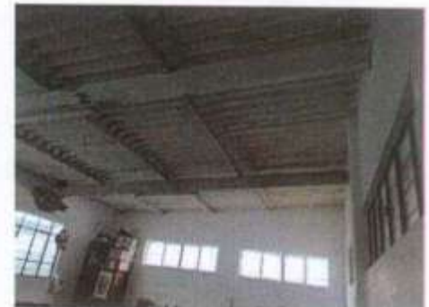
TECHO DEL AULA DE 4 AÑOS
