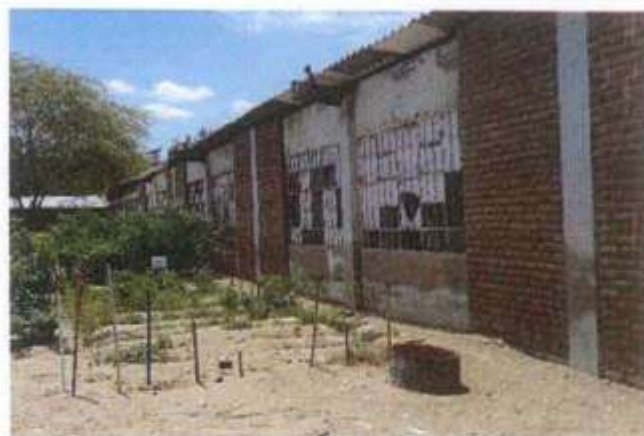
SOBRETECHO CON COBERTURA METALICA EN LOS SS. HH Y MURO DEL MODULO 4. AFECTADOS POR LA HUMEDAD.
