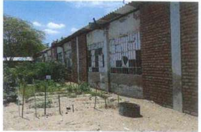
SOBRETECHO CON COBERTURA METALICA EN LOS SS. HH Y MURO DEL MÓDULO 4 AFECTADOS POR LA HUMEDAD.
