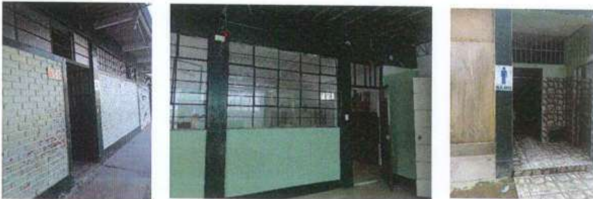
EN LAS IMAGENES SE APRECIA QUE TODOS LOS AMBIENTES TIENEN GRADA EN EL INGRESO
