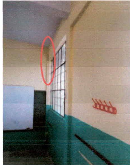
Foto N° 03 y 04: Vista del primer nivel donde no se ha seguido con la misma sección de columna esto afecta estructuralmente la edificación y pone en riesgo la integridad de los estudiantes.
