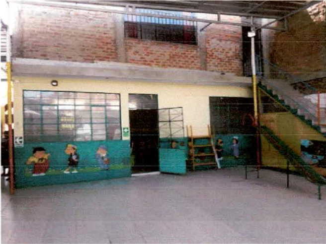
Foto N°01 y 02: Vistas del módulo A, se aprecia la construcción de dos niveles del módulo, la edificación ha sido construido por la APAFA, el cual fue habilita sin asesoramiento técnico, por lo que, a efectos de falla de la estructura, el ambiente del 2do nivel es inhabitable.
