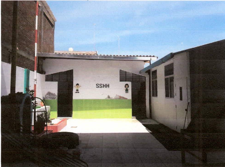
Foto N°22: Vista de la cobertura con estructura metálica que protege el patio de formación de la I.E. El patio de formación, se encuentra en estado regular de conservación.
