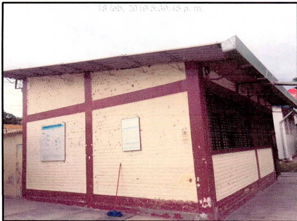
FOTO N°07.- Se observa el aula de cómputo de la I.E.
