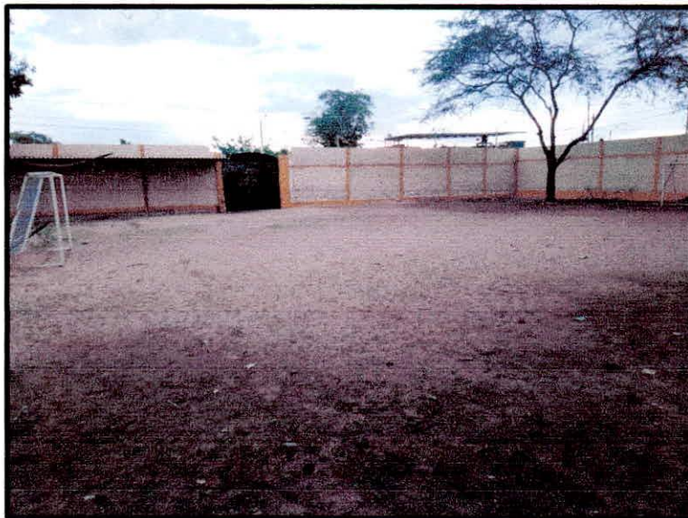
FOTO N°11.- Se observa el cerco perimétrico – portón secundario.
