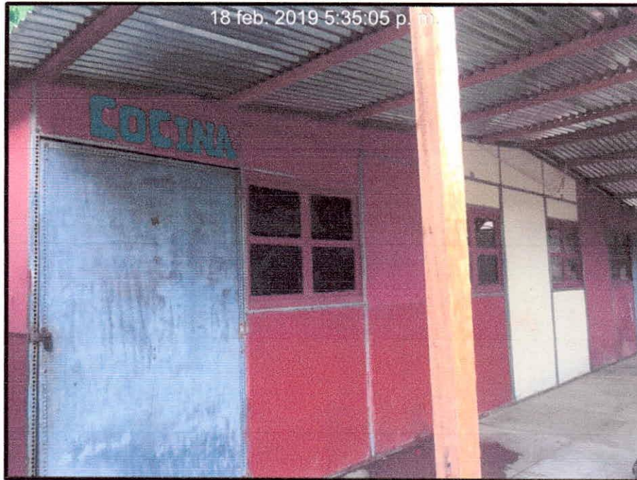
FOTO N°05.- Se observa el módulo de la cocina.
