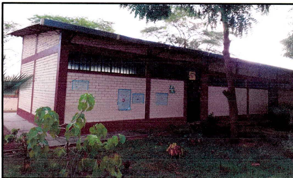
FOTO N°02.- Se observa el módulo de las aulas de la I.E.
