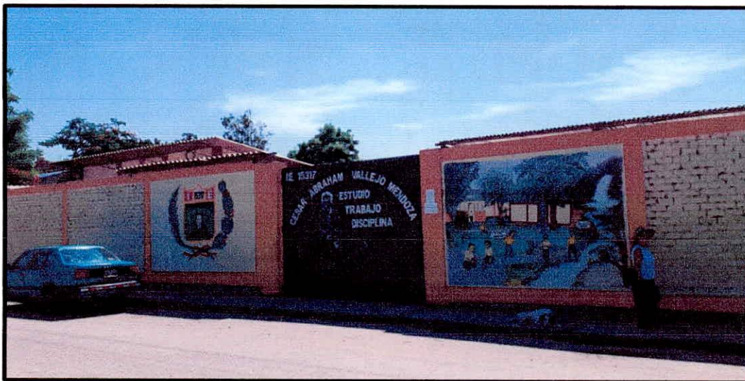
FOTO N°01.- Se observa la fachada de la I.E.
