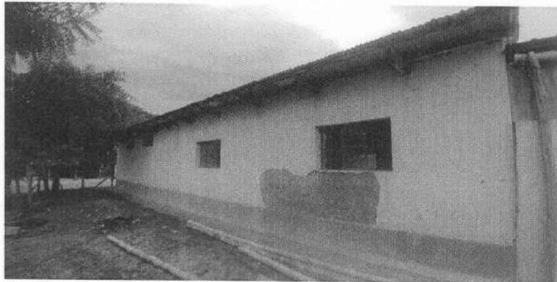
FOTO 14.-AMBIENTES DE ADOBE DETERIORADOS POR LA HUMEDAD Y LA LLUVIA
