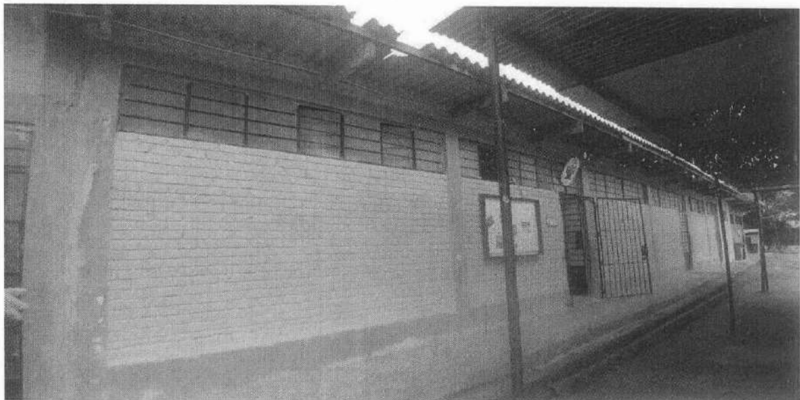
FOTO 4.-VISTA FRONTAL DE LAS AULAS CONSTRUIDAS + ADMINISTRACIÓN (DIRECCIÓN + ARCHIVO+ ESPERA) POR FONCODES EL AÑO 1993. SE VE LA COBERTURA DETERIORADA, VEMOS TAMBIÉN EL PATIO DE SECUNDARIA CON POSTES Y VIGAS SOLERAS METALICOS CON COBERTURA DE CALAMINA Y EL PISO EN TERRENO NATURAL.
