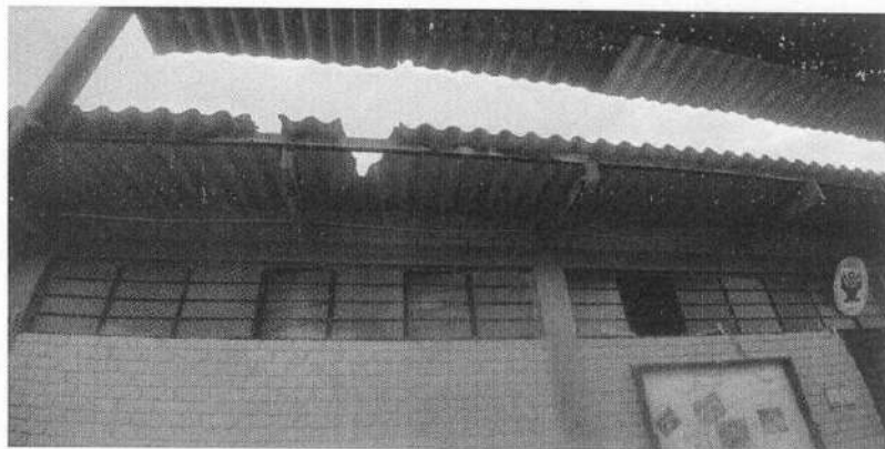
FOTO 14.-AMBIENTES DE ADOBE DETERIORADOS POR LA HUMEDAD Y LA LLUVIA
