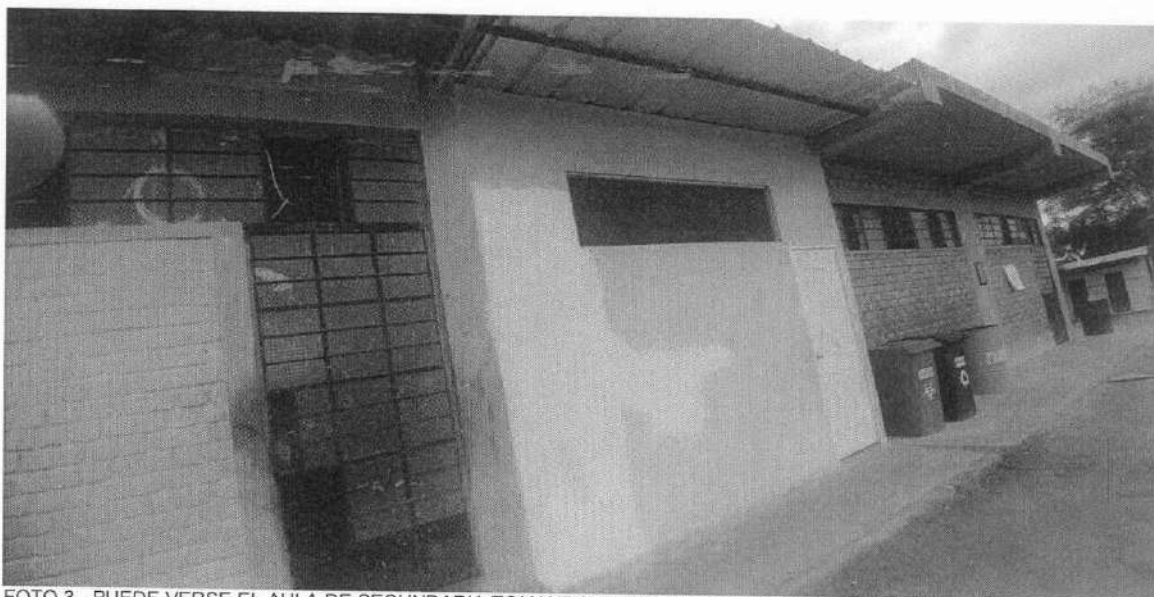
FOTO 3.- PUEDE VERSE EL AULA DE SECUNDARIA TOMANDO EL ESPACIO EXISTENTE ENTRE LAS AULAS CONSTRUIDAS HACE 25 AÑOS POR FONCODES Y EL AULA CONSTRUIDA EL AÑO PASADO. LA PLANCHA DE CARTON YESO (SISTEMA DRYWALL).
