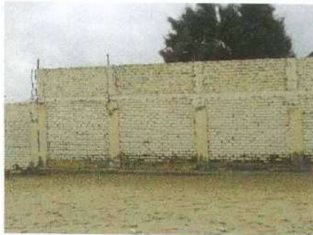
ESTADO ACTUAL DEL CERCO PERIMETRICO CONSTRUIDO CON LADRILLO ARTESANAL
