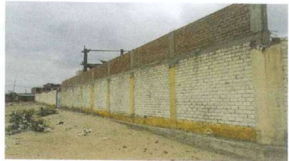
ESTADO ACTUAL DEL CERCO PERIMETRICO CONSTRUIDO CON LADRILLO ARTESANAL
