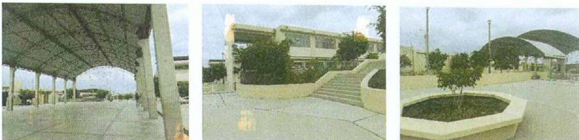
VISTA DEL PATIO 1 DE FORMACION TECHADO. VISTAS DESDE EL NTP+56.75 AL EDIFICIO-03 Y PATIO 1
