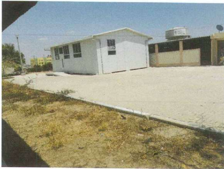
VISTA DEL LADO SUR DEL AULA PROVISIONAL INSTALADA FRENTE AL BLOQUE M-04.
