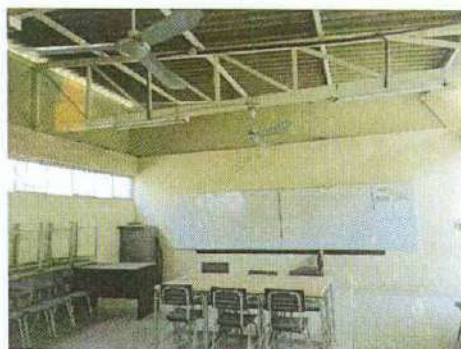
BLOQUE M-01. COBERTURA DE PLANCHA COLOR GRIS DE ASBESTO CEMENTO ANTIGÜEDAD MAS DE 20 AÑOS. ESTAS PLANCHAS YA NO SON IMPERMEABLES Y PRODUCEN FILTRACIONES AL INTERIOR Y A LOS MUROS DE LADRILLO ARTESANAL.
