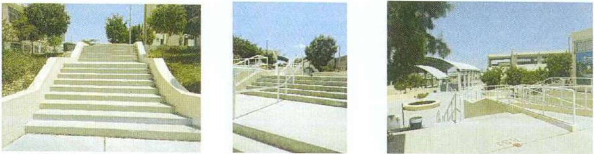
VISTAS DESDE EL NTP +56.75 DE LAS DOS CIRCULACIONES MENCIONADAS. VISTA DEL SECTOR 3 AL SECTOR 2
