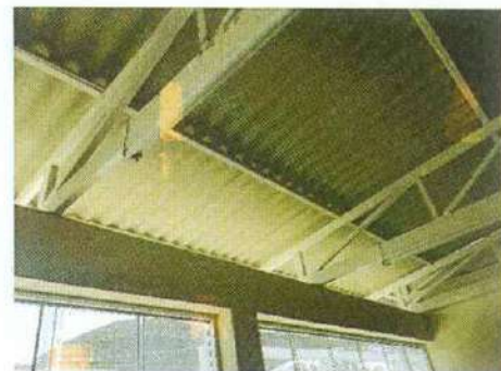
BLOQUE M-01. COBERTURA DE PLANCHA COLOR GRIS DE ASBESTO CEMENTO ANTIGÜEDAD MAS DE 20 AÑOS. ESTAS PLANCHAS YA NO SON IMPERMEABLES Y PRODUCEN FILTRACIONES AL INTERIOR Y A LOS MUROS DE LADRILLO ARTESANAL.
