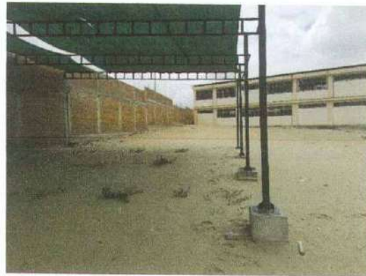
ESTADO DE LA CIMENTACION DEL BLOQUE M-04 Y DEL ACTUAL COMEDOR
