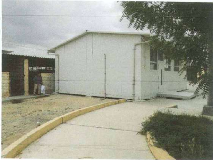
VISTA DEL LADO NORTE DEL AULA PROVISIONAL INSTALADA FRENTE AL BLOQUE M-04.
