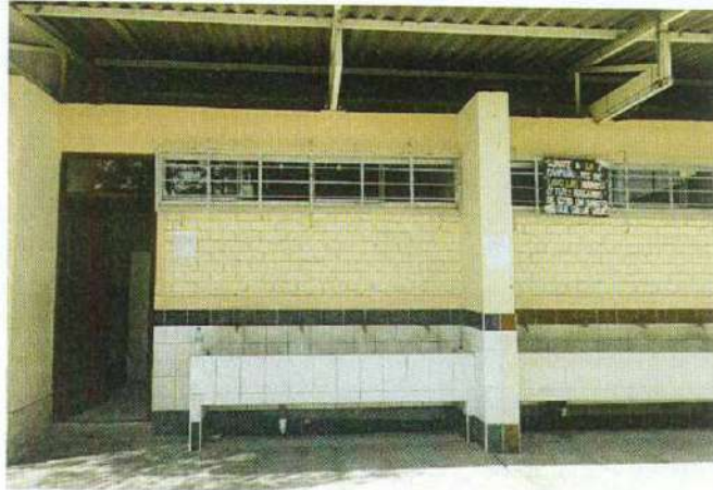
Vista exterior SS.HH
