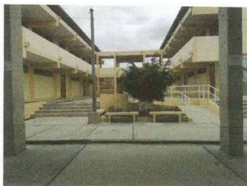
EDIFICIO-01 Y EDIFICIO-02 CON COBERTURA COBERTURA
