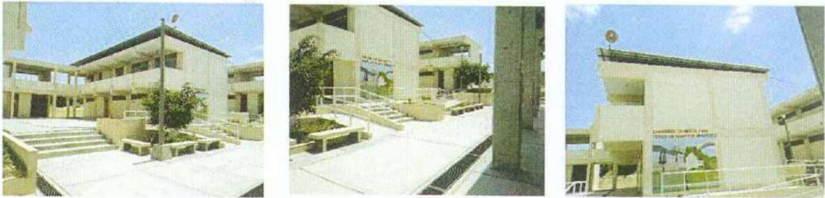
EDIFICIO-02 Y EDIFICIO-03 VISTOS DESDE EL PATIO DE FORMACION. SE APRECIA LAS GRADAS Y RAMPAS DE ACCESO.
