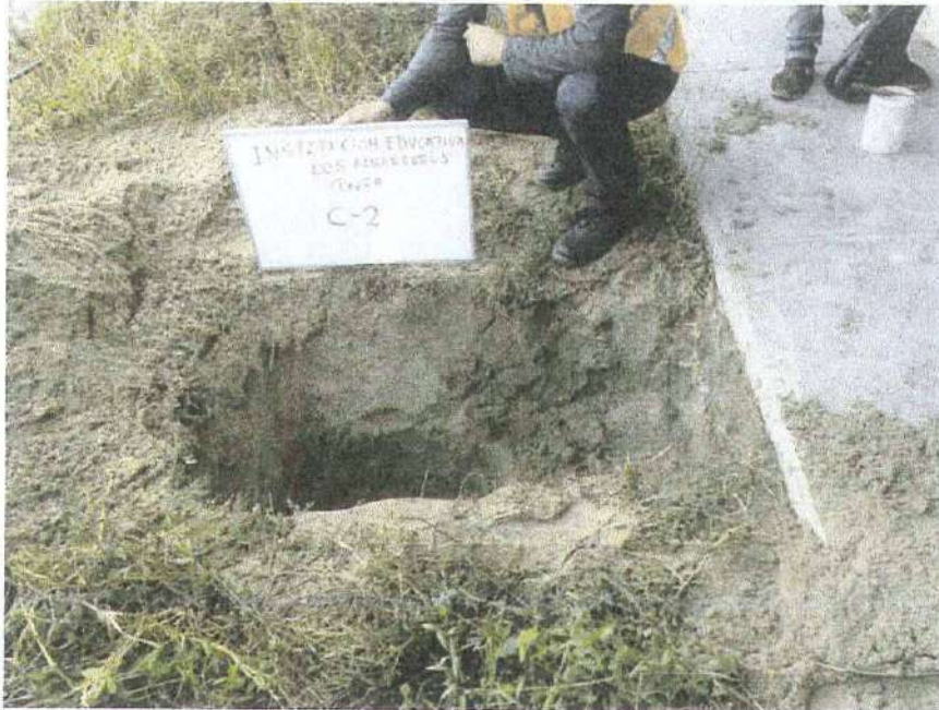
CALICATA Nº 02 – SE OBSERVA PERFIL DE CALICATA TERMINADA
