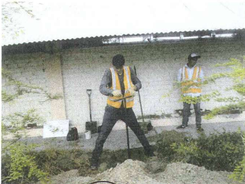
CALICATA Nº 02 – PROFUNDIZANDO EXCAVACION CON BARRENO
