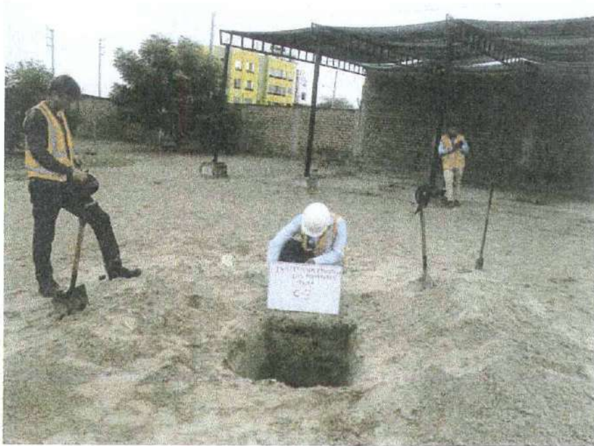
CALICATA N° 03 – SE OBSERVA EL PERFIL DE CALICATA TERMINADA
