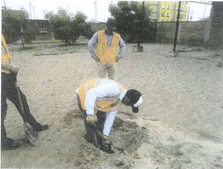
CALICATA N° 03 – REALIZANDO EXCAVACION A CIELO ABIERTO
