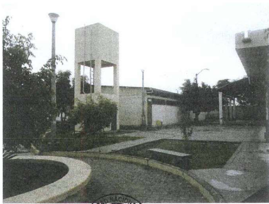
SE OBSERVA TANQUE ELEVADO Y AULAS EXISTENTES
