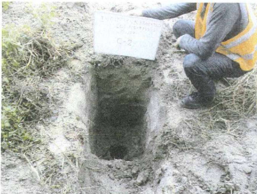
CALICATA Nº 02 – SE VISUALIZA EL FONDO DE LA EXCAVACION
