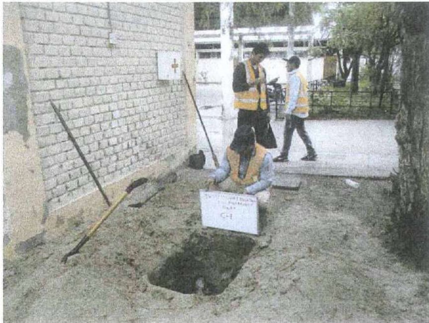
CALICATA Nº 01 – SE OBSERVA PERFIL DE CALICATA TERMINADA
