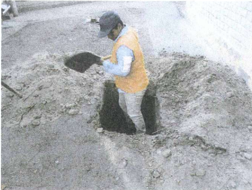
CALICATA Nº 02 – REALIZANDO EXCAVACION A CIELO ABIERTO
