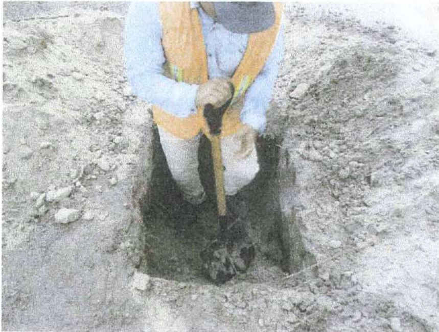
CALICATA Nº 01 – REALIZANDO EXCAVACION A CIELO ABIERTO
