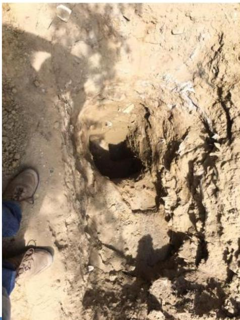
Se encontró en la Calicata N°02 presencia de napa freática, la misma que debe de tenerse en cuenta en el momento de realizar el diseño estructural de la cimentación.
