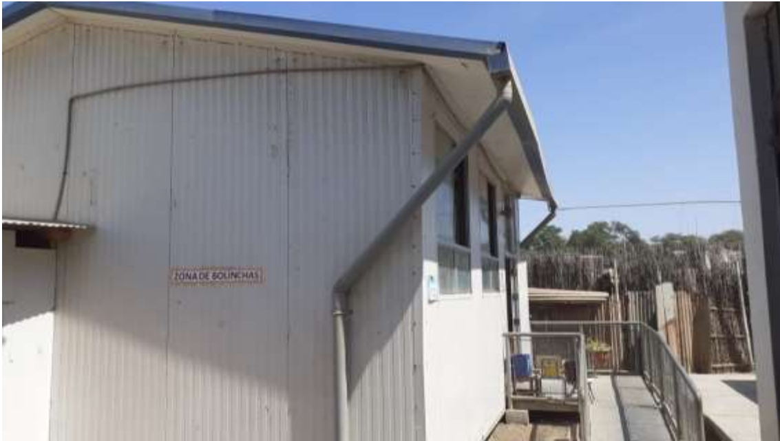
Foto N° 19: Vista lateral del MODULO 10 (aula de 4to grado): se aprecia el estado de regular conservación del módulo, además el poco confort que recibirán alumnos y docentes por el material en un clima como el de la costa. El sistema de drenaje desagua a menos de un metro del módulo.
