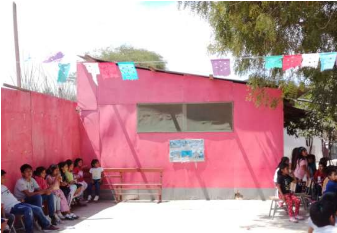
Foto N° 26: Vista exterior lateral del aula de 5to grado (MODULO 12)
