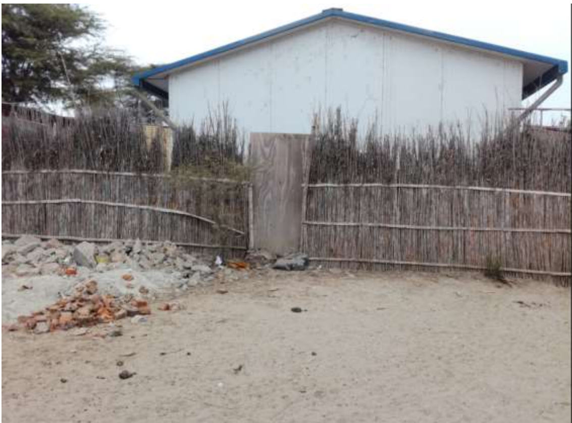
Foto N° 20: Vista lateral del MODULO 10.
