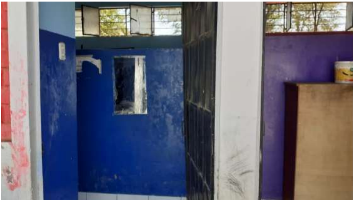
Foto N° 15: Vista interior del MODULO 8, se constata la falta de sistema eléctrico, de servicios para discapacitados, e higiene.
