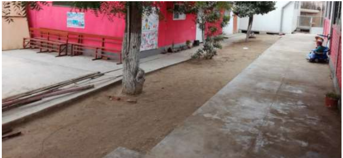
Foto N°35: Veredas de circulación: desgaste por abrasión, fisuras por debilitamiento de base por presencia de lluvias e inundaciones. Además las raíces de los arboles han levantado las veredas.
