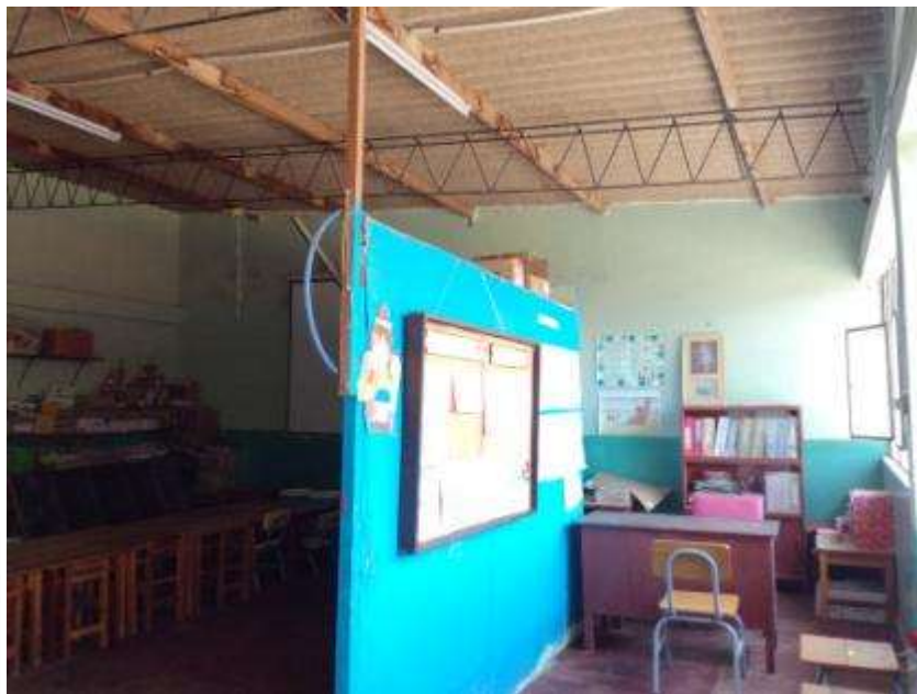
Foto N° 6: Vista el interior de la dirección (MODULO 3), sin presencia de instalaciones eléctricas que cubran la demanda, el techo de fibrocemento soportado por tijerales y viguetas de madera sin protección contra bichos e insectos.
