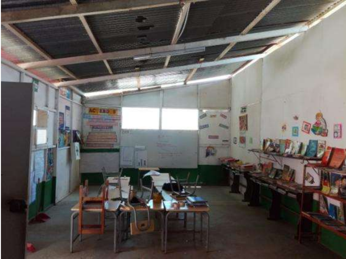
Foto N° 25: Vista interior lateral del aula de 5to grado (MODULO 12), material prefabricado, dando un bajo nivel de servicio para alumnos y profesores.
