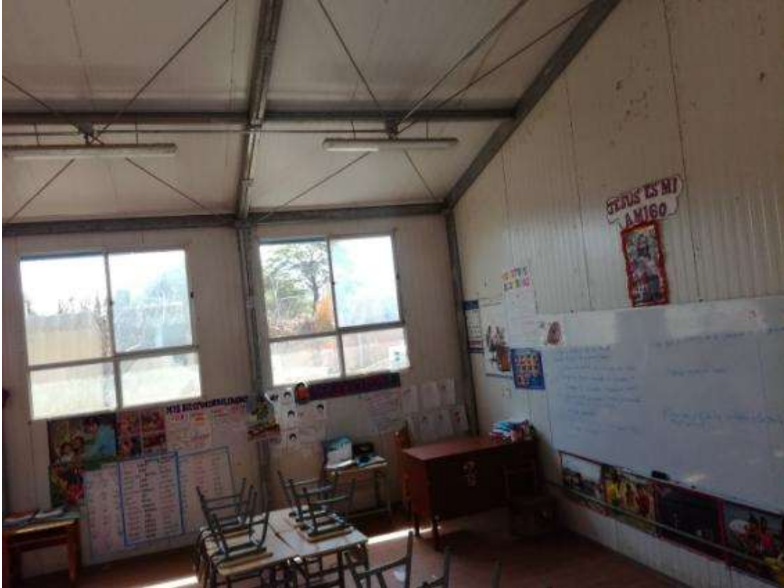
Foto N° 21: Vista interior del módulo prefabricado (MODULO 10)
