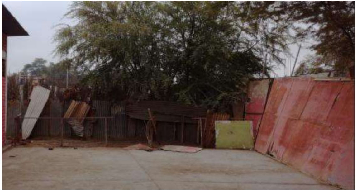
Foto N°32: Vista de Cerco Perimétrico de la parte trasera del local. Los materiales son calaminas de depósitos de reciclaje y planchas de triplay en estado obsoleto.
