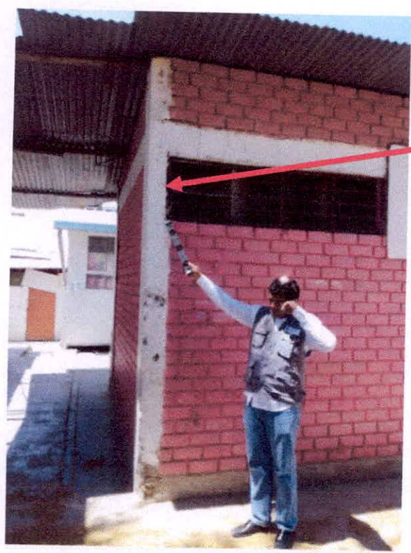
Imagen N°13: Vista posterior del módulo 7, columna corta en lado superior
