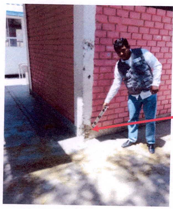
Imagen N°14: Vista posterior del módulo 7, columna corta en lado inferior
