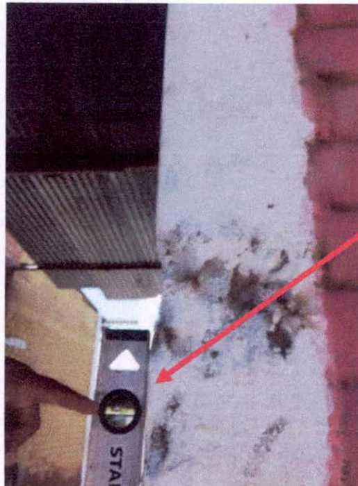
Imagen N°15: Columna corta y desplomada de la parte frontal del modulo J
