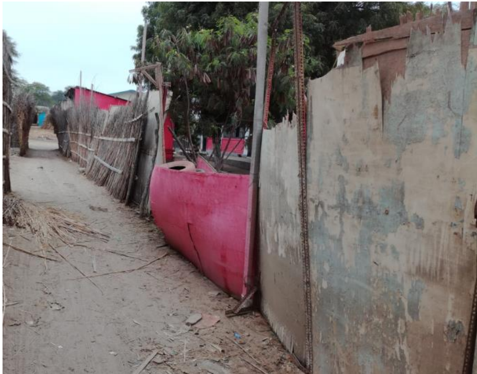
Foto N°03: Vista de cerco perimétrico de material rústico.
