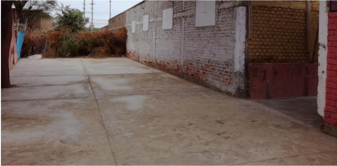
Foto N°06: Vista interior del local escolar 15313.
