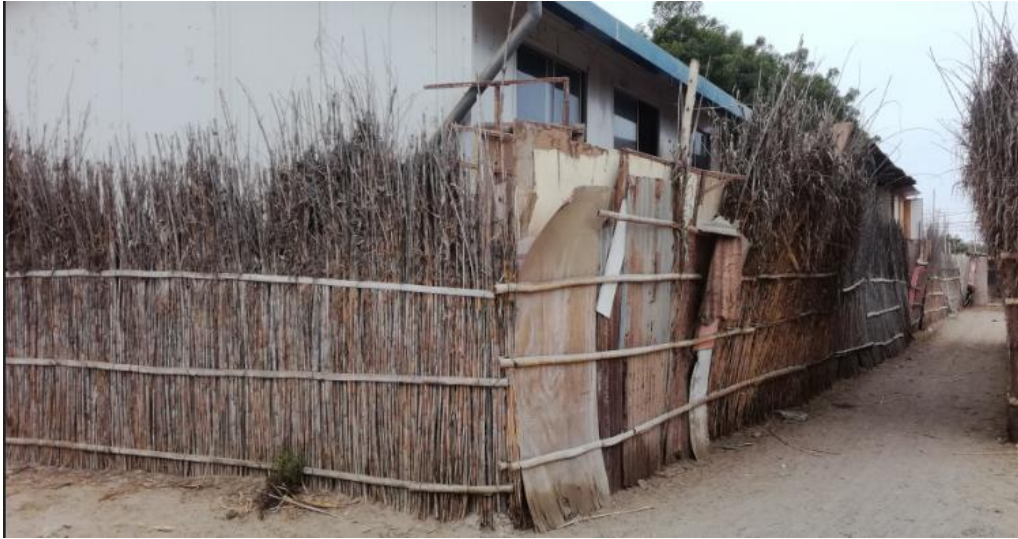
Foto N°04: Vista de cerco perimétrico de material rústico.
