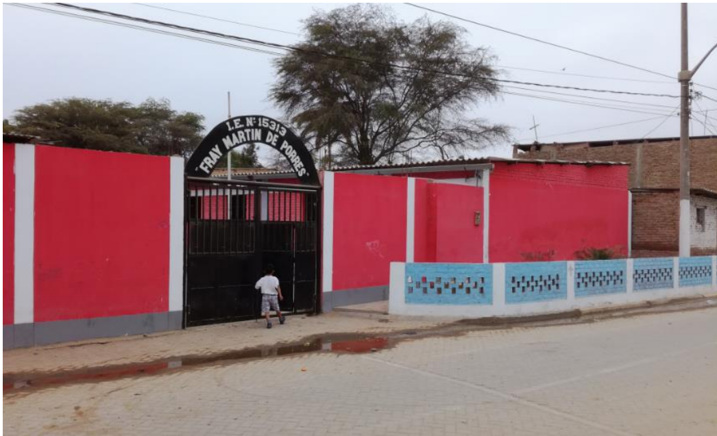
Foto N°01: Vista de Fachada
