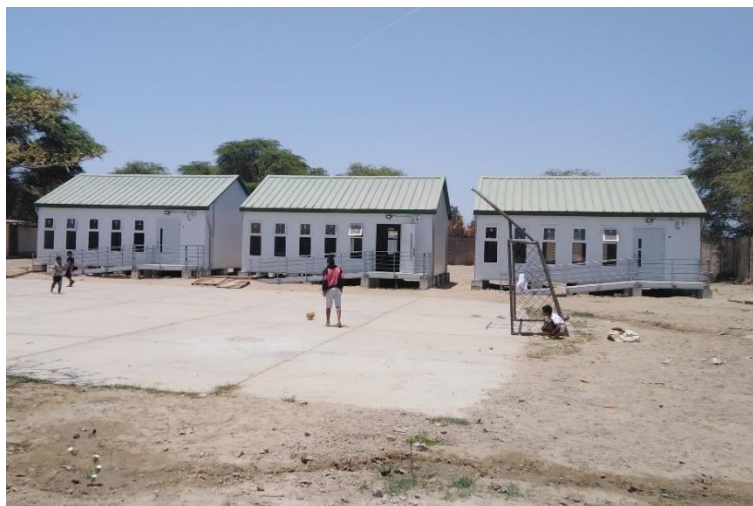
Foto N°10 Los módulos 6, 7 y 8 Son de material Prefabricado.
