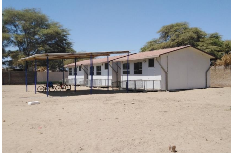
Foto N°09 Los módulos 3, 4 y 5 Son de material Prefabricado.
