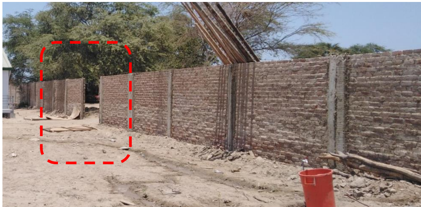
FotoN°17: De material noble fue construido hace 22 años. Su estado es malo. Como se observa durante la inundación de 2017 se cayeron varios paños.
