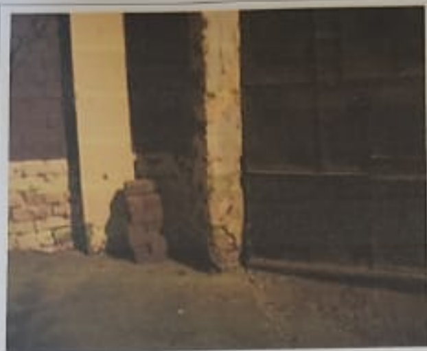
Foto 01 y 02: Desprendimiento de concreto en columnas del cerco perimétrico, con aceros expuestos.
