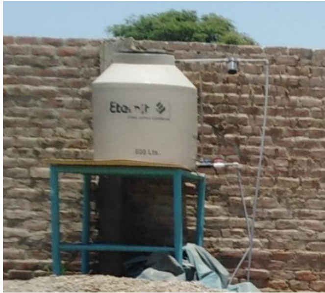
FotoN°16: El tanque elevado 03 es de estructura metálica y el contenedor es de polipropileno. Su estado es regular. Fue adquirido por la APAFA.
