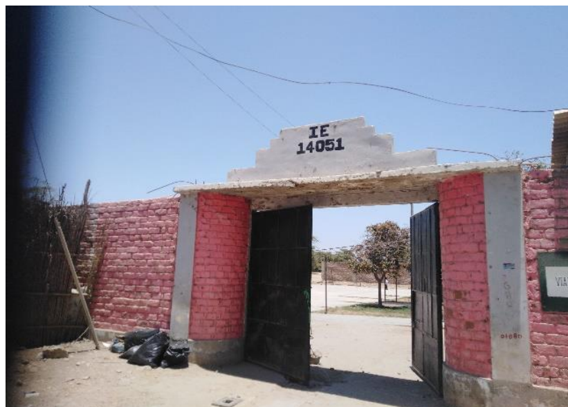
Foto N°01: Vista del ingreso a la I.E. 14051.
