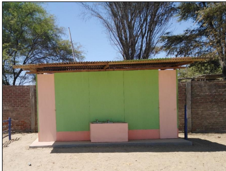
Foto N°09: SS.HH. de inicial. De material de triplay fue realizado por la APAFA.
