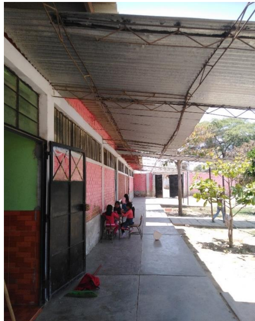
Foto N°12: Vista de la circulación del módulo de aulas.
