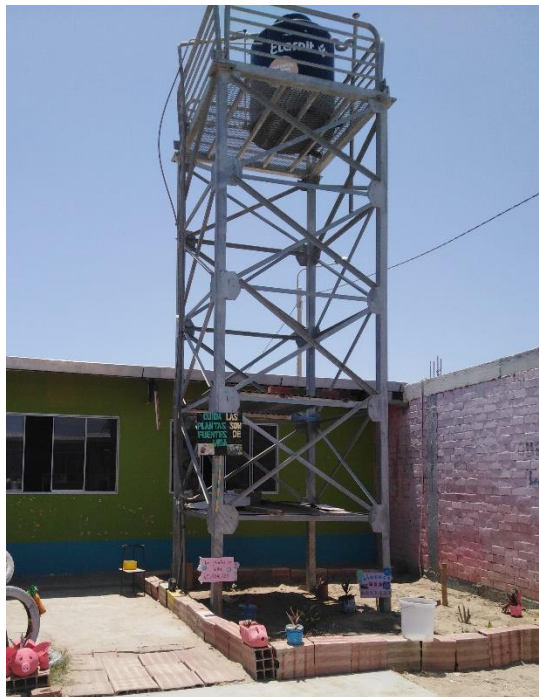
Foto N°12: Es de estructura .
