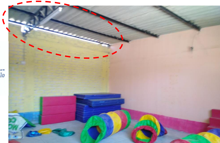
Foto N°04: (Aula psicomotricidad) Al usar el muro del cerco como cerramiento ha Dejado espacio entre el muro y la cobertura permitiendo la filtración del agua de lluvia.
