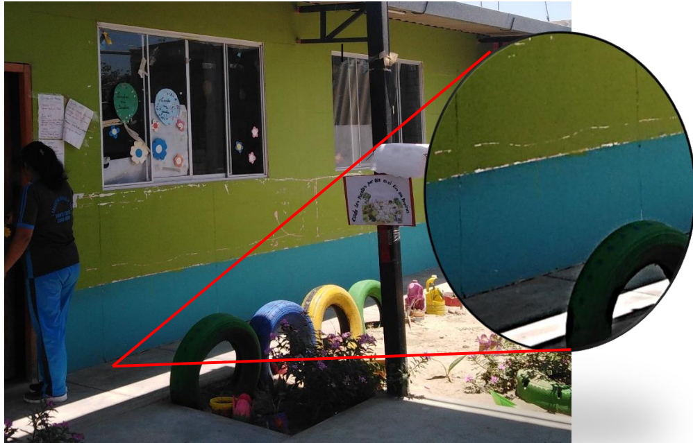
Foto N°06: En la parte posterior se observa que el drywall se esta deteriorando producto de las lluvias.
