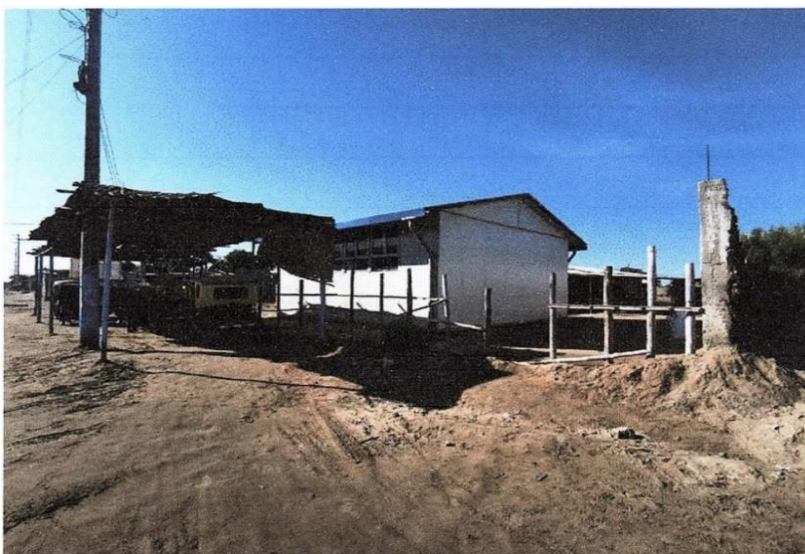
Foto N° 12: Vista desde la calle 08 de Diciembre, se aprecia el aula prefabricada y un cerco en esta zona de caña Guayaquil.
