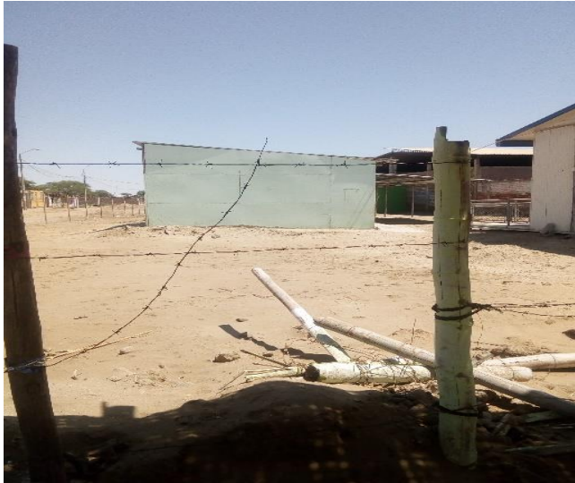
Foto N°11: Vista del cerco de palos con alambre de puas.
