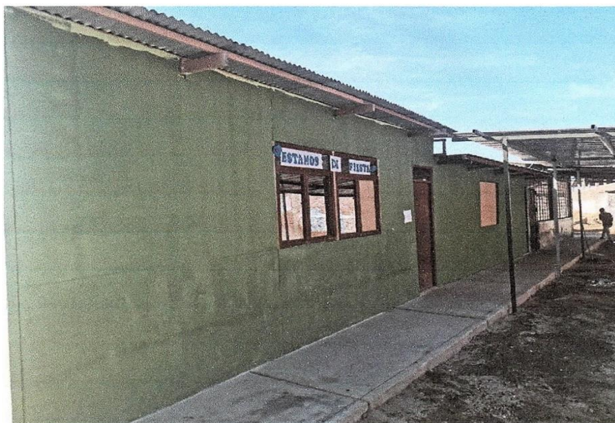
Foto N° 16: Vista del interior hacia la zona de aulas de triplay, esta zona se encuentra en regular estado de conservación, pero no es un material adecuado para el desarrollo de actividades escolares.
