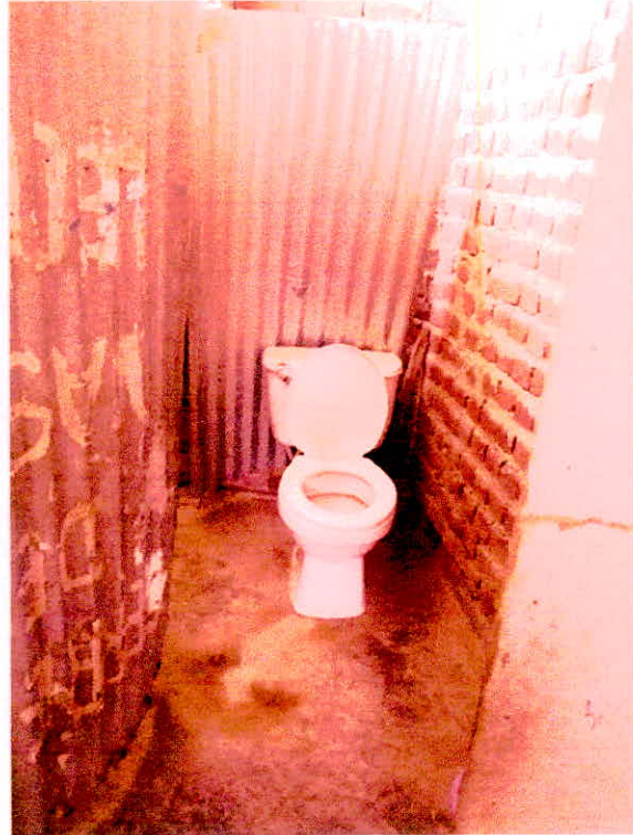
Fotos N°08 y 09: SS.HH. de niños y niñas fuera de la normativa con muros deteriorados en su base por la humedad al no contar con tarrajeo, no presentan elementos de confinamiento. Los servicios carecen de dotación de agua, con acabados en mal estado, tabiques improvisados, fallas estructurales en muros.
