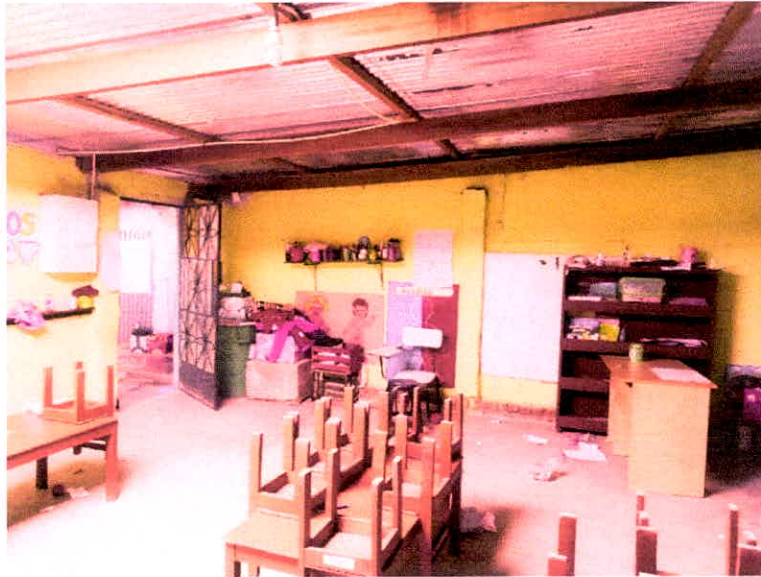
Foto 19: Zona de interior de Aulas se muestra el mobiliario educativo existente.
