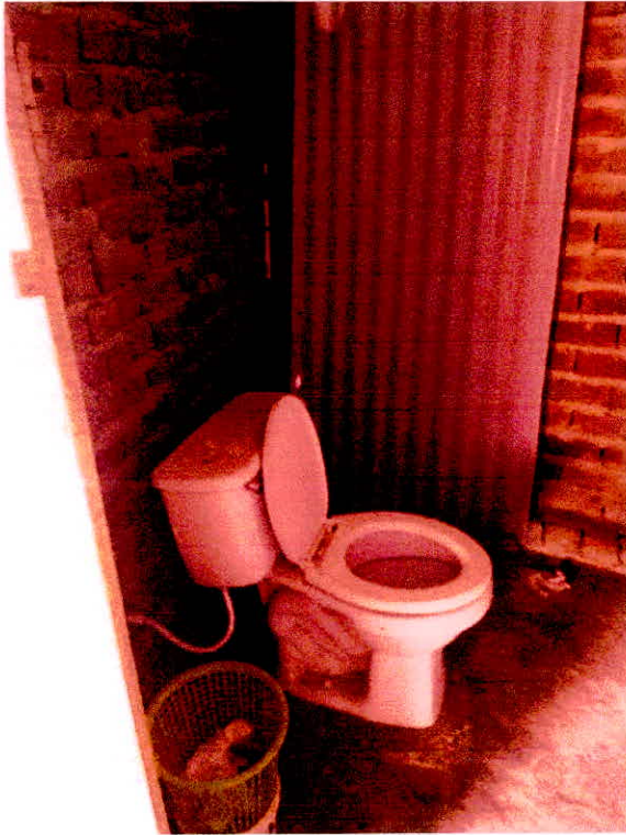
Fotos N°08 y 09: SS.HH. de niños y niñas fuera de la normativa con muros deteriorados en su base por la humedad al no contar con tarrajeo, no presentan elementos de confinamiento. Los servicios carecen de dotación de agua, con acabados en mal estado, tabiques improvisados, fallas estructurales en muros.
