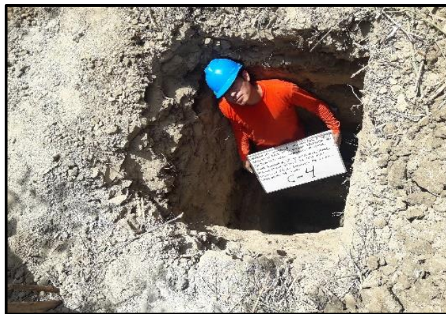
Fotografía N° 1: Excavación manual de calicata
