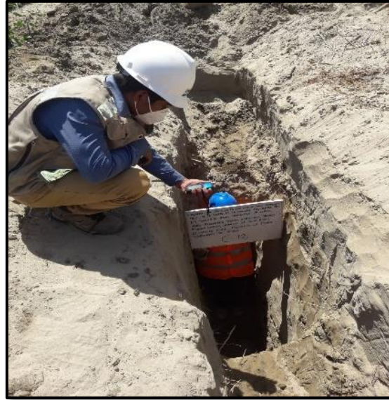
Fotografía N° 4: excavación manual
