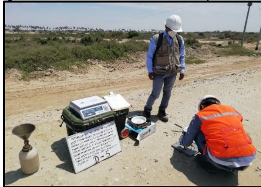
Fotografía N° 7: Perforación del hueco para densidad
