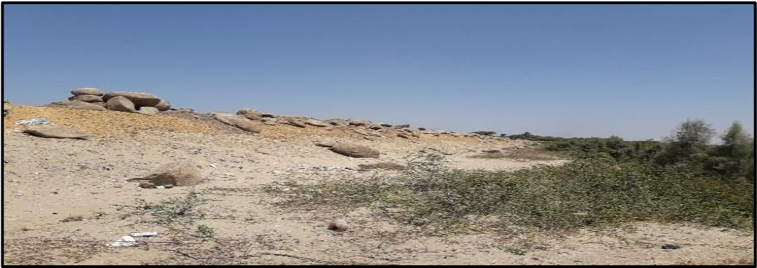
EROSIÓN DE RIBERA
