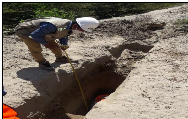
Fotografía N° 2: Medición de profundidad de calicata
